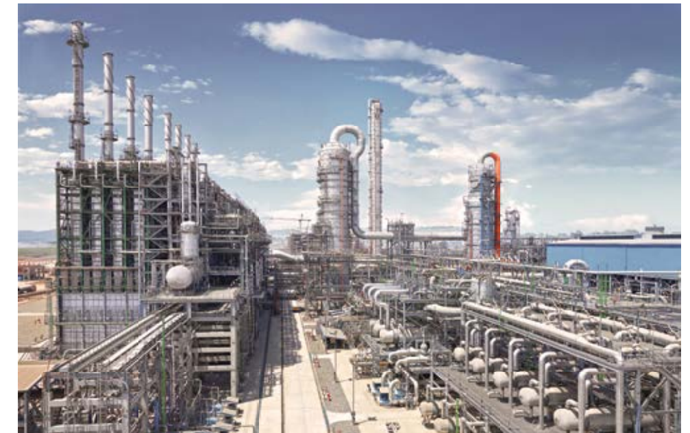
India, OPaL DFCU & AU Project
