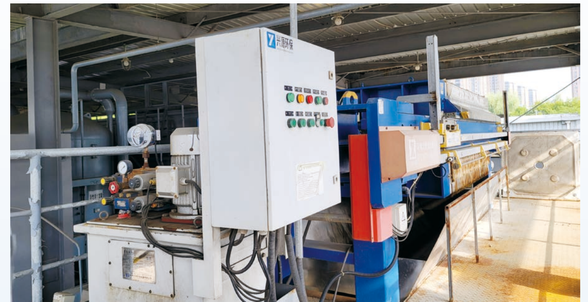
污泥减量化设施改造
