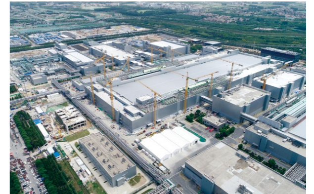
三星（中国）半导体二期项目建设现场
