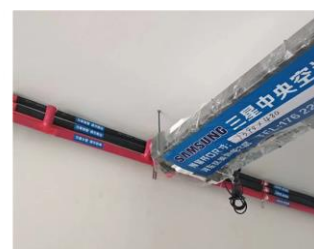
Высокий уровень требований к монтажным работам Samsung Electronics
