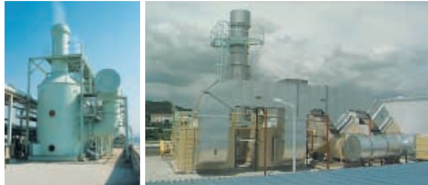
세정집진시설 VOC 처리시설
